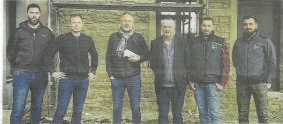
Le maire Gilles Gelas (au centre), entouré de l'architecte et des acteurs des différentes sociétés, à l'occasion d'une visite de chantier. Photo Le DL/Marianne Bois
