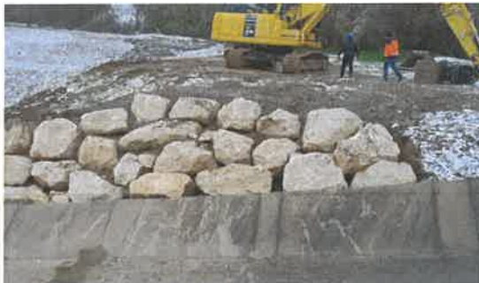
Renforcement du talus du déversoir par un enrochement.
