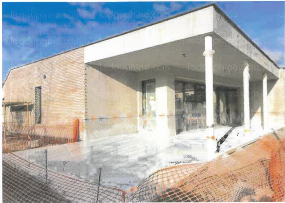
La façade sud-ouest de la mairie, en plein chantier.
