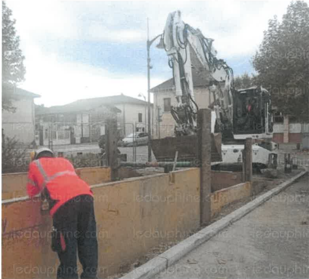
Des travaux importants pour des blocs enterrés.
