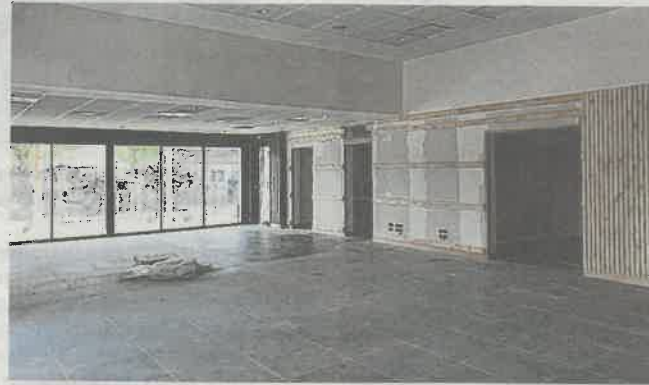
La salle du conseil et des mariages est encore en travaux.
