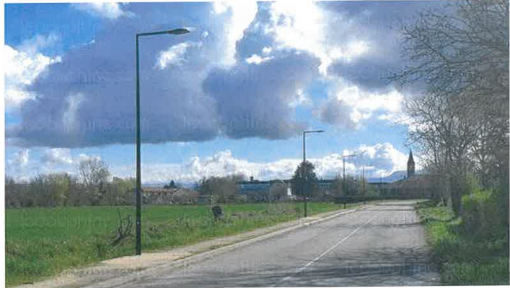
Des nouveaux lampadaires ont été installés pour la sécurité et le confort des usagers.
