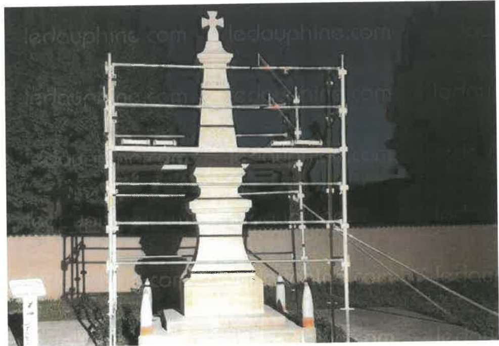
Les travaux ont commencé.
